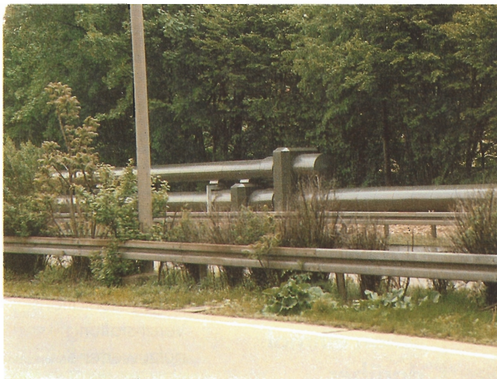
Eckentlasteter Axialkompensator gut in die Landschaft eingebracht
